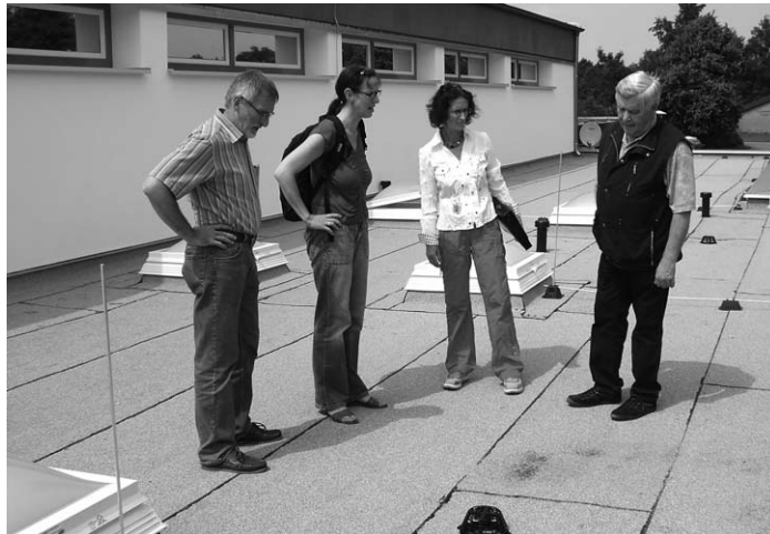
Die sanierten Dachflächen werden abgenommen - v.l. Siegfried Schmidt, Erika Jahn, Margot Wagner, Hans-Heinrich Jensen-Hansen
