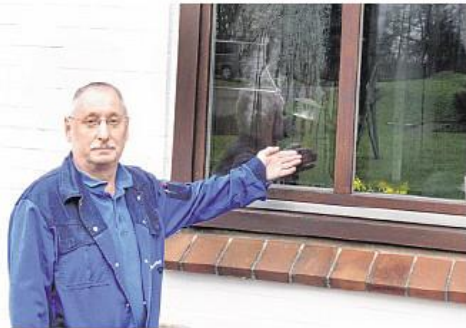
Hausmeister Helmut Kindler hält die Renovierungen für notwendig. Dieses Fenster lässt sich nicht mehr öffnen. KETELS
